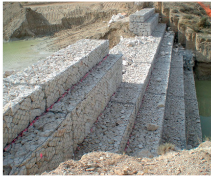
Diques de Gavión Transversal
